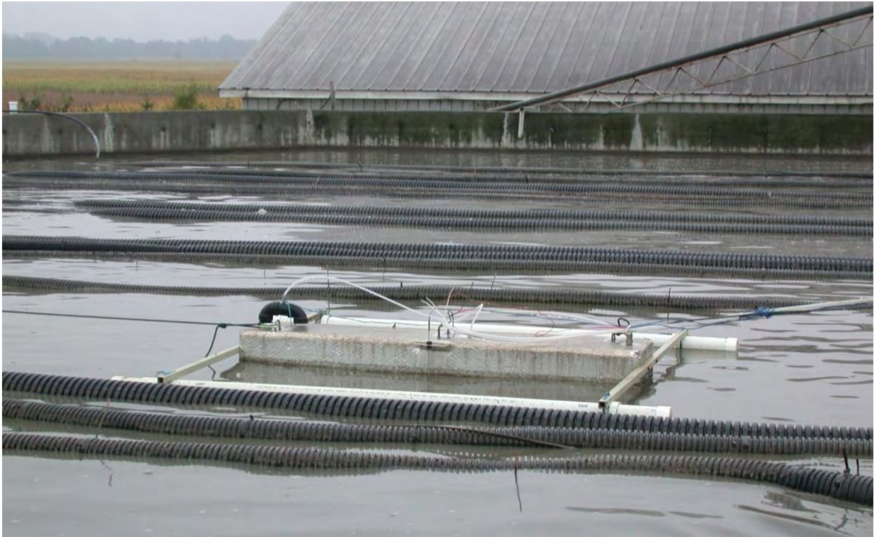
Figure 6. Chambre de prélèvement sur le bioréacteur #1
