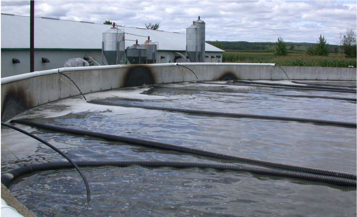
Figure 2. Tuyau de drain non perforé à la surface du lisier dans le bioréacteur #2
